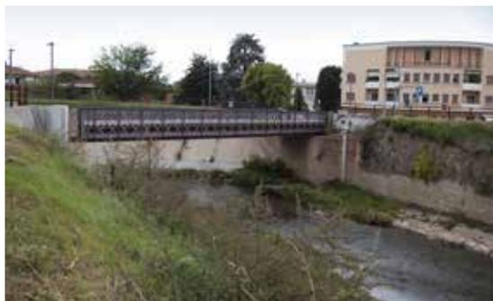
La nuova struttura permettere di avere due corsie di marcia più una passerella per il passaggio pedonale e ciclabile.
