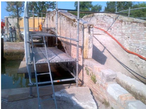
Il sistema è applicabile anche su supporti umidi e senza l'uso di protezioni speciali: C-Mesh 84/84 mantiene la normale traspirabilità del supporto anche alle temperature molto elevate o in relazione ai cicli di gelo/disgelo, evitando la formazione di condensazione superficiale, possibile fonte di degrado per le strutture murarie; la matrice inorganica MX-C 25 Muratura, inoltre, possiede una notevole capacità adesiva al supporto e compatibilità chimico-fisica alla muratura.
