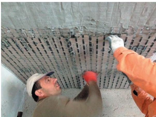
Di facile installazione, **il sistema X Plaster è composto dal pannello Stucanet e dalla specifica malta da intonaco fibrorinforzata Plasterwall**, leggera e traspirante, ideale per realizzare presidi antisfondellamento su tutti i tipi di solaio sia in interno che in esterno.
