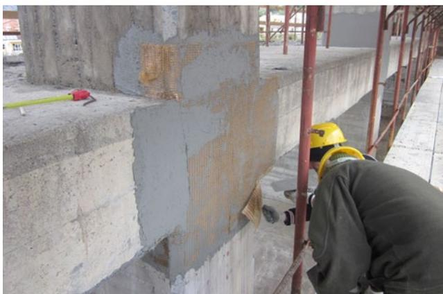
Ruregold PBO-Mesh 70/18 permette di migliorare la resistenza a flessione semplice, taglio e pressoflessione di pilastri e travi, incrementare la duttilità dell'elemento strutturale rinforzato e delle parti terminali di travi e pilastri, la resistenza dei nodi trave-pilastro, la capacità di dissipazione dell'energia e l'affidabilità delle strutture anche in presenza di sovraccarichi di tipo ciclico come in caso di sisma.
