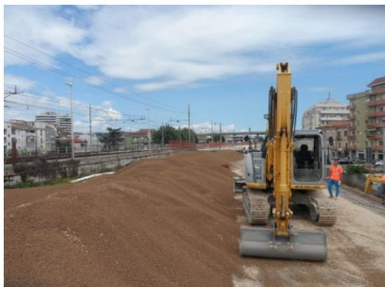
di campagna; l'ulteriore particolarità è che il rilevato oltre ad essere alleggerito con argilla espansa è anche contenuto con le tecniche delle "terre rinforzate". Si è poi proceduto alla stesura dello strato di alleggerimento in argilla espansa LecaPiù 8-20 con mezzi meccanici, rispettando
