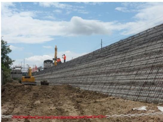
scrupolosamente la stratigrafia di progetto, che ha previsto un modulo da 70 cm costituito da uno strato da 55 cm di argilla espansa e uno strato da 15 cm di materiale di riempimento tradizionale. La posa dello strato di alleggerimento, la cui realizzazione ha comportato **l'impiego di circa 5.000 m<sup>3</sup>**
