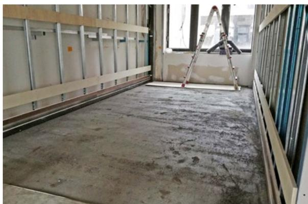
anche 250 m di **bandella adesiva perimetrale Calpestop**, dello spessore di 5 mm e di 10 cm di altezza. Calpestop è una linea composta da materassini elastici in polietilene espanso reticolato chimicamente a cellule chiuse studiata per
