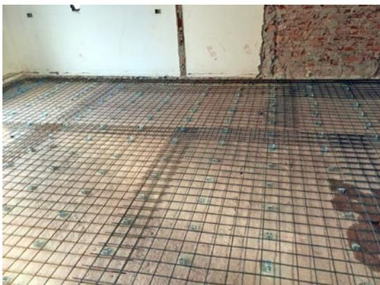
L'impresa esecutrice, infatti, in opera ha riscontrato la **necessità di rinforzare i solai esistenti**. L'esigenza di cantiere, quindi, era quella di riqualificare i solai **rispettando le altezze interne e gravando il meno possibile sulla struttura esistente**.
